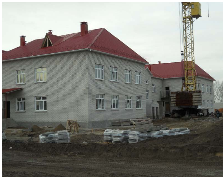
Строительство детского сада
